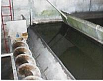
Damit bei Regen die ARA nicht überläuft, wird überschüssiges Wasser ins Regenbecken geleitet. Hier werden Schwimmstoffe und absetzbare Stoffe zurückgehalten. Ist der Regen vorbei, wird das Becken mit Pumpen entleert und das Abwasser auf die ARA geleitet.
