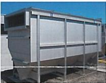
Durch den Lufteintrag bildet sich eine Wasserwalze, die den Sand im Sandfang absetzen lässt. Der anfallende Sand wird im Sandwäscher gewaschen und im Kieswerk verwertet. Aufschwimmende Stoffe wie Fette werden abgezogen und der Kehrichtverbrennung zugeführt.
