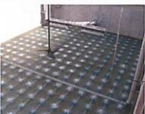
Während der Befüllung der SBR-Becken wird mit dem Rührwerk das Abwasser aus dem Vorlagebehälter mit dem vorhandenen Belebtschlamm im SBR-Becken gemischt. Anschliessend wird mit der Zufuhr von Sauerstoff eine optimale Umgebung für die Bakterien und die Kleinstlebewesen geschaffen, welche die gelösten Stoffe im Abwasser abbauen.
