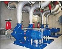
Die SBR-Becken werden nicht stetig sondern in Zyklen befüllt. Das bedingt ein Zwischenspeichern des Abwassers im Vorlagebehälter. Mit einem Rührwerk wird das Absetzen der Schmutzstoffe verhindert. Das Abwasser wird mit Pumpen abwechselungsweise in eines der fünf SBR-Becken gefördert.
