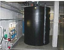
Um Phosphate aus dem Abwasser zu eliminieren, werden Chemikalien zudosiert. Mit dem im Vorlagebehälter zudosierten Eisenchlorid oder Aluminiumsulfat werden die gelösten Phosphate in eine absetzbare Flockenform überführt und zusammen mit dem Überschussschlamm aus dem Abwasser entfernt.
