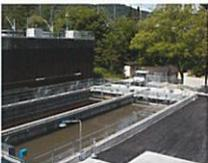
Als Folge der geringen Fließgeschwindigkeit setzen sich Feststoffe ab. Der Rümer schiebt den Schlamm und die aufschwimmenden Partikel der Abwassereinflaufseite zu, wo sie abgezogen und der Schlammbehandlung zugeführt werden.
