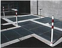
Im Kiesfang setzen sich grössere Steine und Kies ab. Mit dem Saugwagen werden die Ablagerungen regelmässig entfernt. Mit einer grobblasigen Belüftung werden unerwünschte Ablagerungen durch Abwasserbestandteile verhindert.
