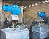
Mit der zweiteiligen Kompaktanlage, bestehend aus Feinrechen und Sandfang, wird das Abwasser mechanisch gereinigt. Mit dem Feinrechen werden Feststoffe aus dem Abwasser entfernt. Das Rechengut wird gewaschen und entwässert, in einem Container gesammelt und der Kehrichtverbrennung zugeführt.
