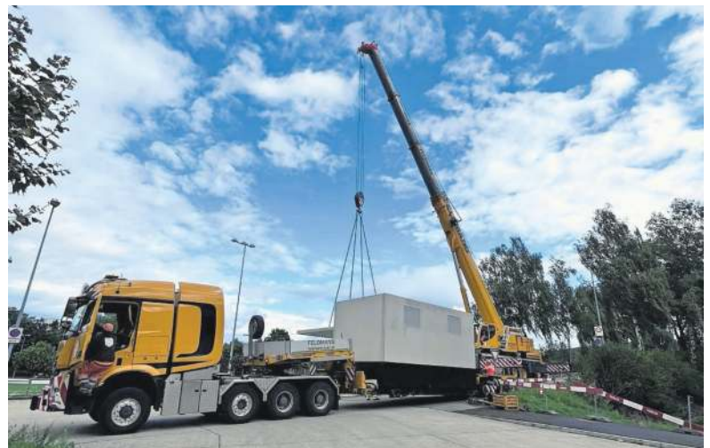
Trafostation wird zur Bushaltestelle Ikea gebracht.
