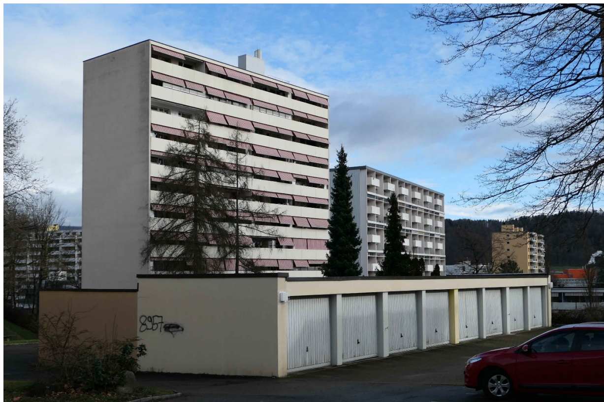
Bahnhofstrasse 59 (vorne) und 68 (2020)
