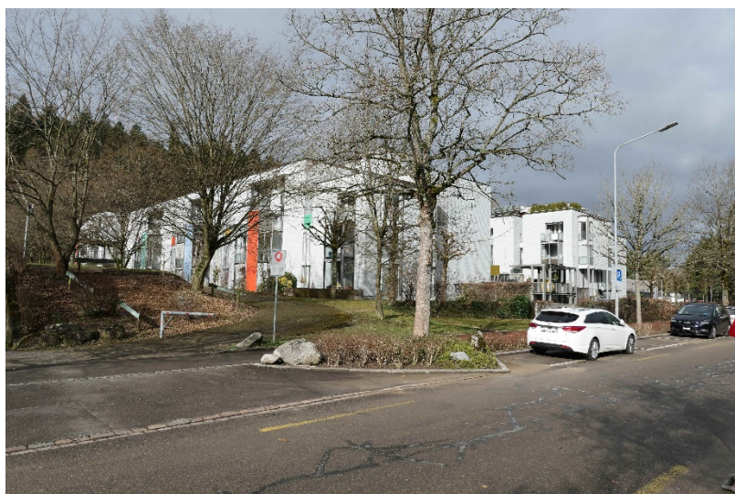
Gesamtansicht von Osten (2020)
