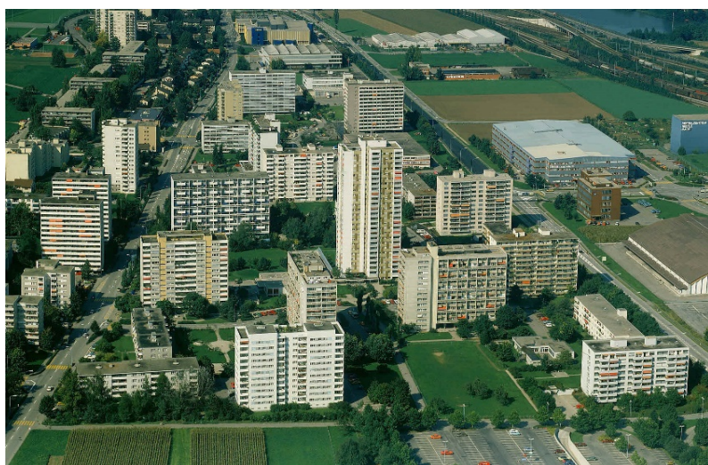
Luftbild von Südosten, 1982 (ETH-Bibliothek Zürich)
