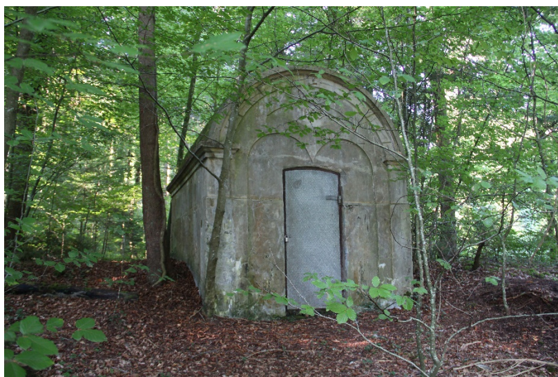
Schieberhaus des Wasserreservoirs (2020)
