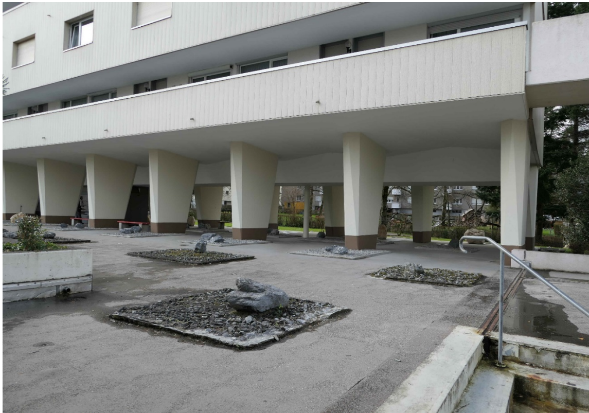
Langäckerstrasse 28, «bellavista», offenes Pfeilergeschoss (2020)
