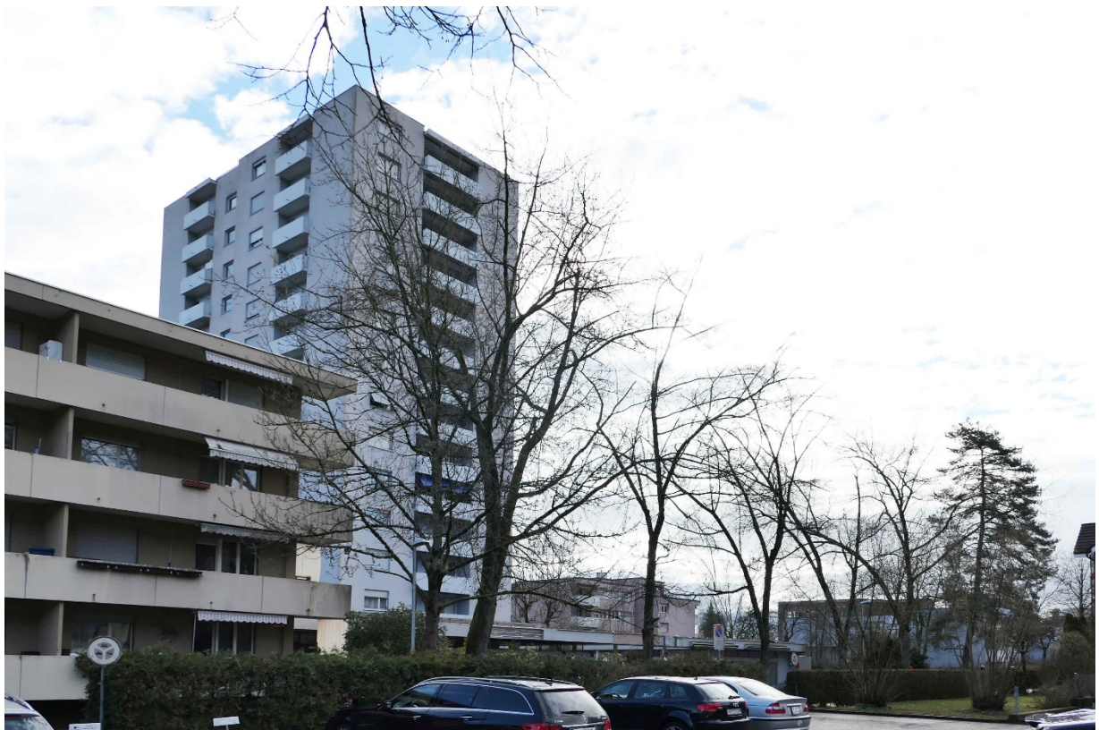
Glattlerweg 12 von Südwesten (2020)
