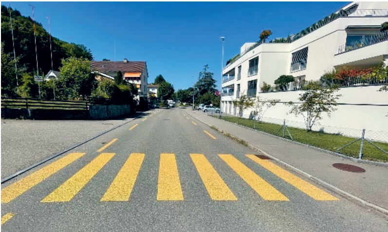
Abbildung 5; Beispiel für eine Kernfahrbahn an der Poststrasse in Spreitenbach
